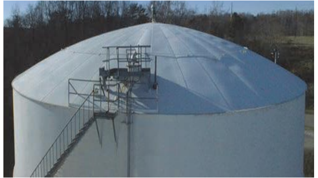
Fig. 2 – Tanque con techo tipo paraguas.
