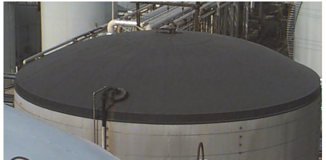
Fig. 4 – Tanque con techo autosoportado.
