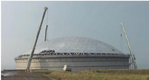
Fig. 3 – Tanque con Domo Geodésico.
