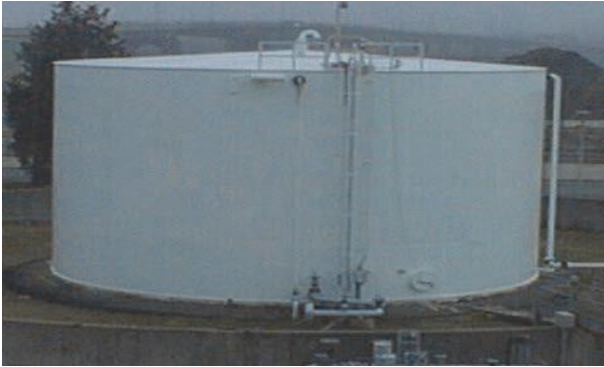
Fig. 1 – Tanque con techo cónico.
