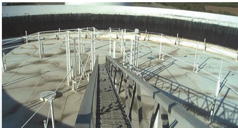
Fig. 5 – Tanque con techo flotante tipo PAN.
